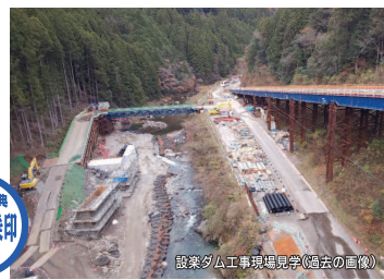
設楽ダム工事現場見学(過去の画像)
