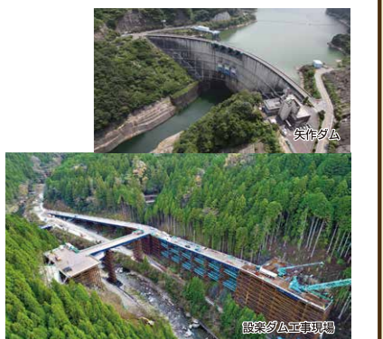
設楽ダム工事現場
