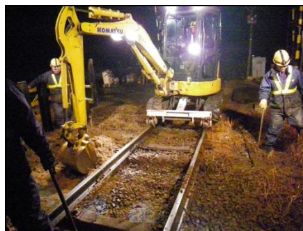
道床交換工事
