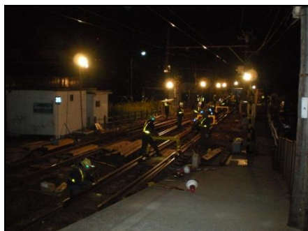
分岐器更换工事
