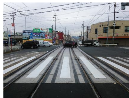
東田本線軌道敷改修工事（東田坂上）
