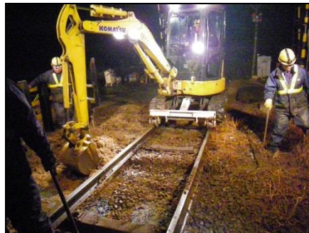
道床交換工事
