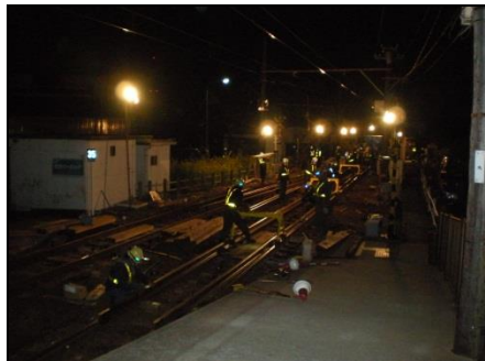
分岐器更换工事
