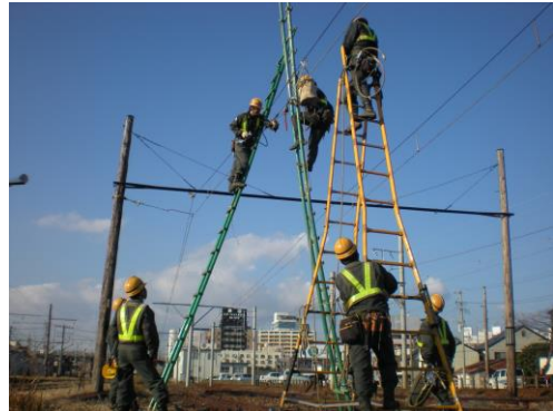
電気区 断線復旧訓練
