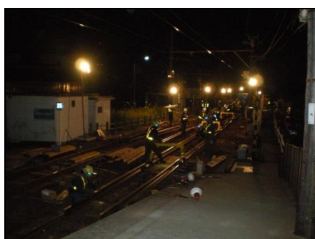
分岐器更換工事
