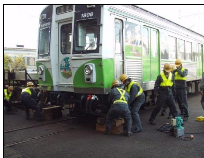
車両区 脱線復旧訓練
