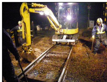
道床交换工事
