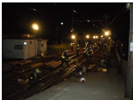
分岐器更换工事
