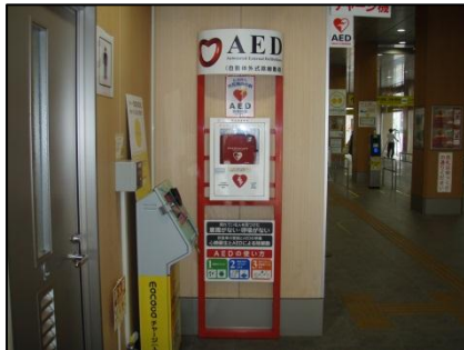
新豊橋駅に設置した AED
