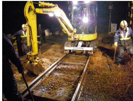
道床交換工事
