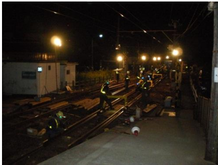
分岐器更换工事
